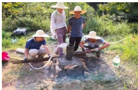
图 9 施工的水文孔
